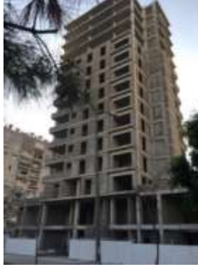
Şekil 2. Seyhan’da yapım süreci devam eden binanın mevcut halini gösteren resim (genel görünüm)
