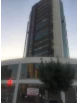
Şekil 4. Seyhan’da kullanılmakta olan binanın mevcut halini gösteren resim (genel görünüm)
