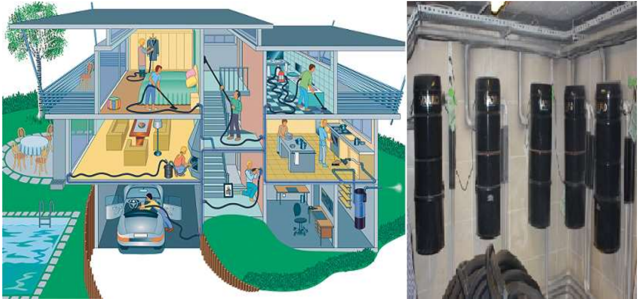
Şekil 2. Örnek merkezi süpürge sistemi [10-11]
