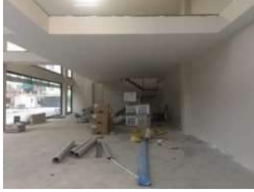
Şekil 1a. Seyhan’da kullanılmakta olan binanın zemin ve asma katının mevcut halini gösteren detay resim (2 ve 3 konu başlıklarına aykırı gelişen ruhsatlı oluşum)
