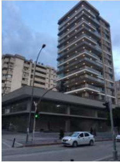
Şekil 1. Seyhan'da kullanılmakta olan binanın mevcut halini gösteren resim (genel görünüm)
