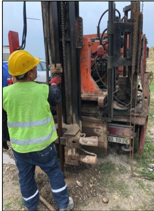
Şekil 4.8. Çalışma alanında yapılan sondaj çalışmaları
