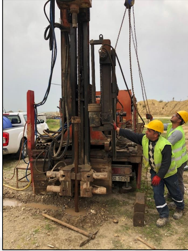
Şekil 4.7. Standart Penetrasyon Testi (SPT)
