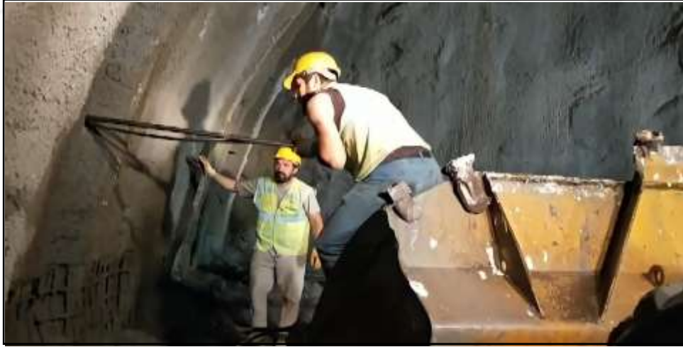
Şekil 4.21. Bulonlama işlemine ait bir görüntü
