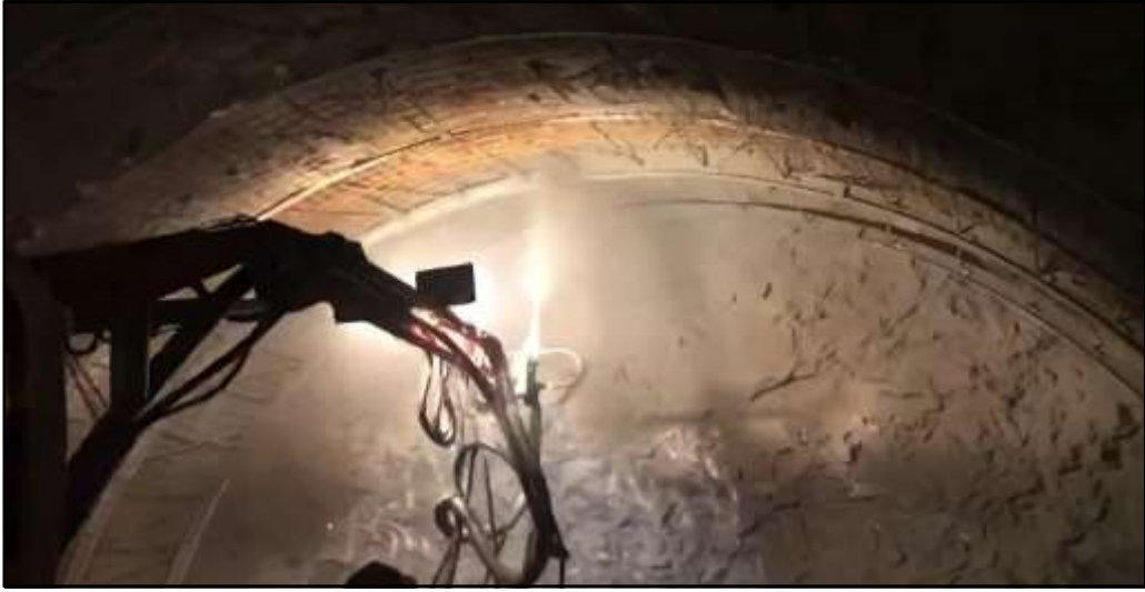
Şekil 4.17. Püskürtme Beton uygulamasına ait bir görüntü
