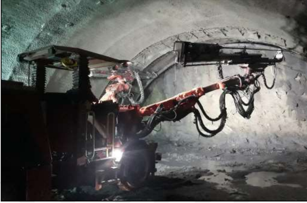
Şekil 4.12. Süren delgisi uygulamasına ait bir görüntü
