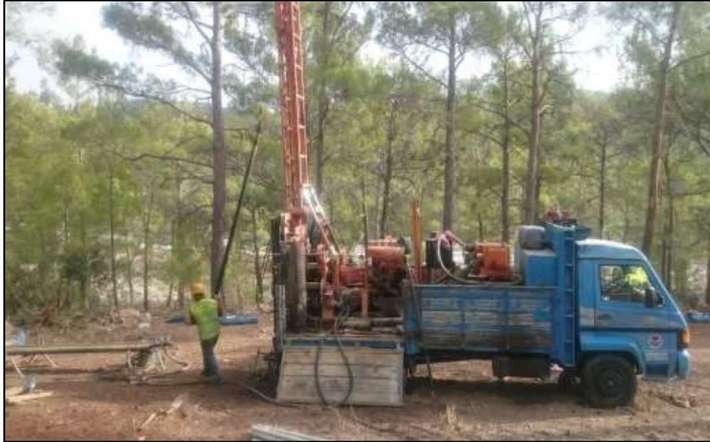
Şekil 3.8.Sondaj çalışmalarından bir görünüm
