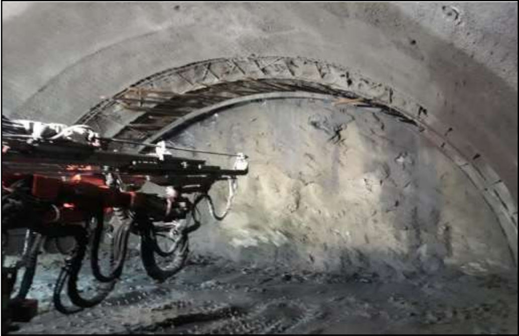
Şekil 4.13. Süren montajına ait bir görüntü
