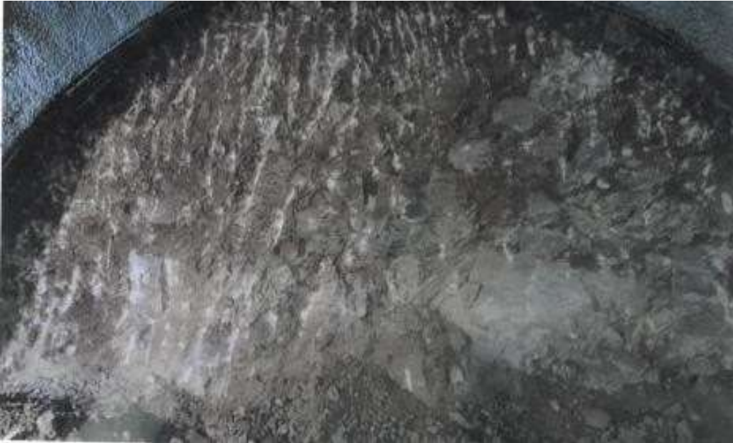
Şekil 4.2. 140+510,72 km'ye ait ayna fotoğrafı
