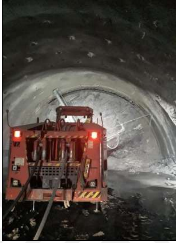
Şekil 4.20. Bulon delgisi açılma safhası
