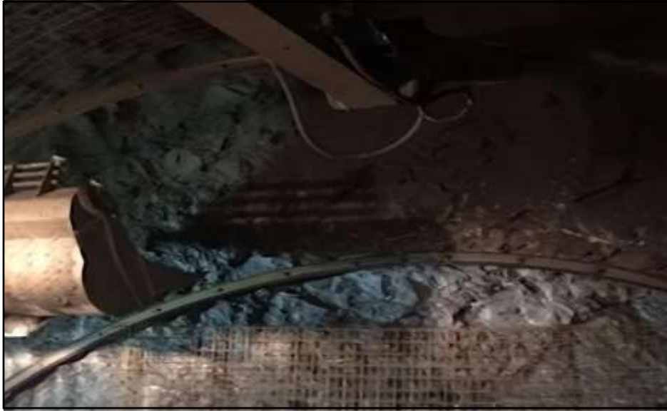
Şekil 4.15. Çelik İksa uygulamasına ait bir görüntü
