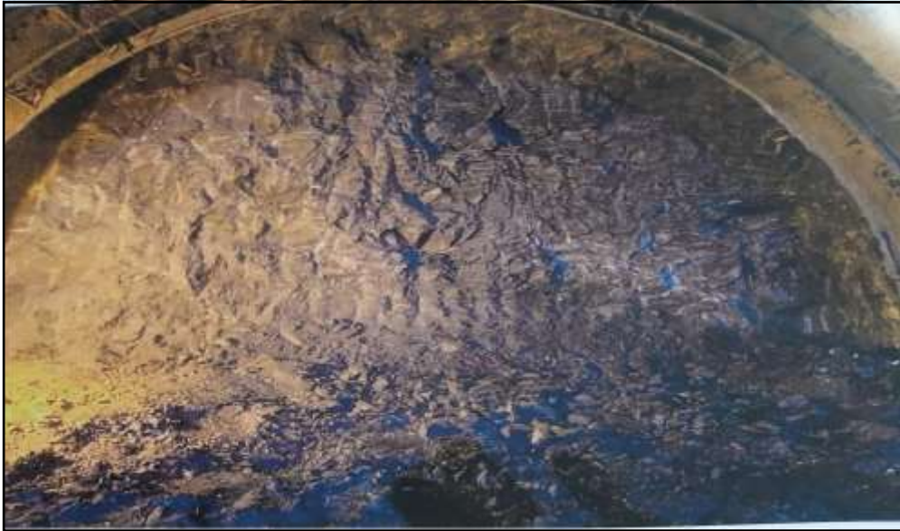
Şekil 4.1 140+320,47 km'ye ait ayna fotoğrafı
