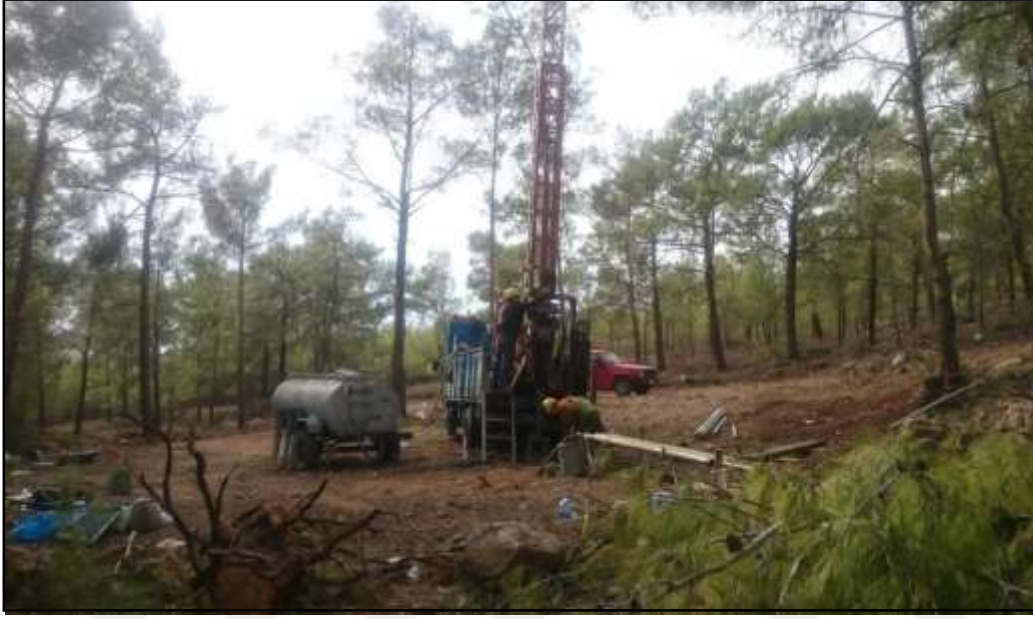
Şekil 3.7.Sondaj çalışmalarından bir görünüm
