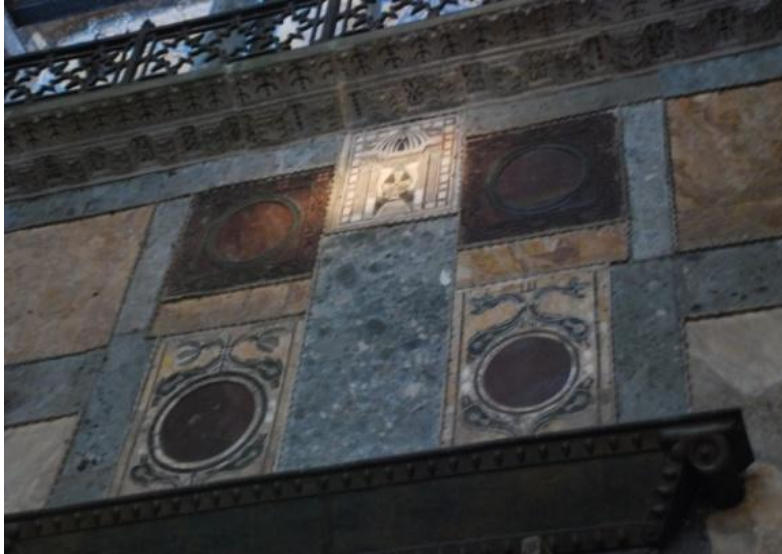
Şekil 3.41. Ayasofya'nın İmparator Kapısı üzerindeki mermer levhaları, (Bilgen, 2011)
