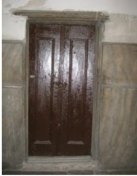
Şekil 3.86. Ayasofya'nın üst katındaki güney galerinin güney yan duvarındaki uçan payandaların iç kısmına bağlanan kapı, (Bilgen, 2011)
