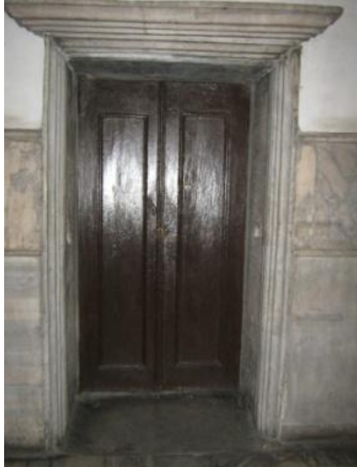
Şekil 3.85. Ayasofya'nın üst katındaki güney galerinin güney yan duvarında şapelin içine bağlanan kapı, (Bilgen, 2011)
