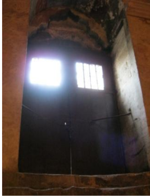
Şekil 3.43. Narteksin güney kapısı (avluya açılır), (Bilgen, 2011)
