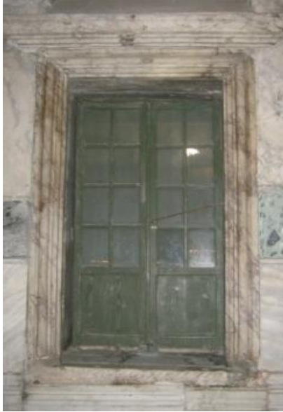
Şekil 3.66. Ayasofya'nın Naos mekânında kuzey yan duvarda ikinci olarak bahsedilen kapı, (Bilgen, 2011)
