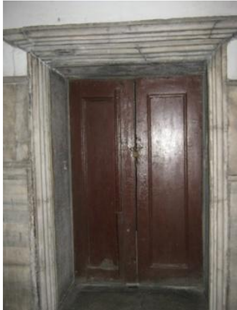
Şekil 3.87. Ayasofya'nın üst katındaki güney galerinin güney yan duvarındaki uçan payandaların iç kısmına bağlanan kapı, (Bilgen, 2011)
