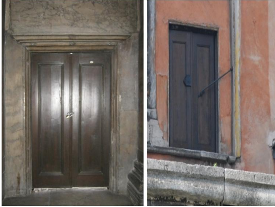
Şekil 3.88. Ayasofya'nın üst katındaki güney galerinin güney yan duvarındaki uçan payandaların iç kısmına bağlanan kapı, (Bilgen, 2011)
