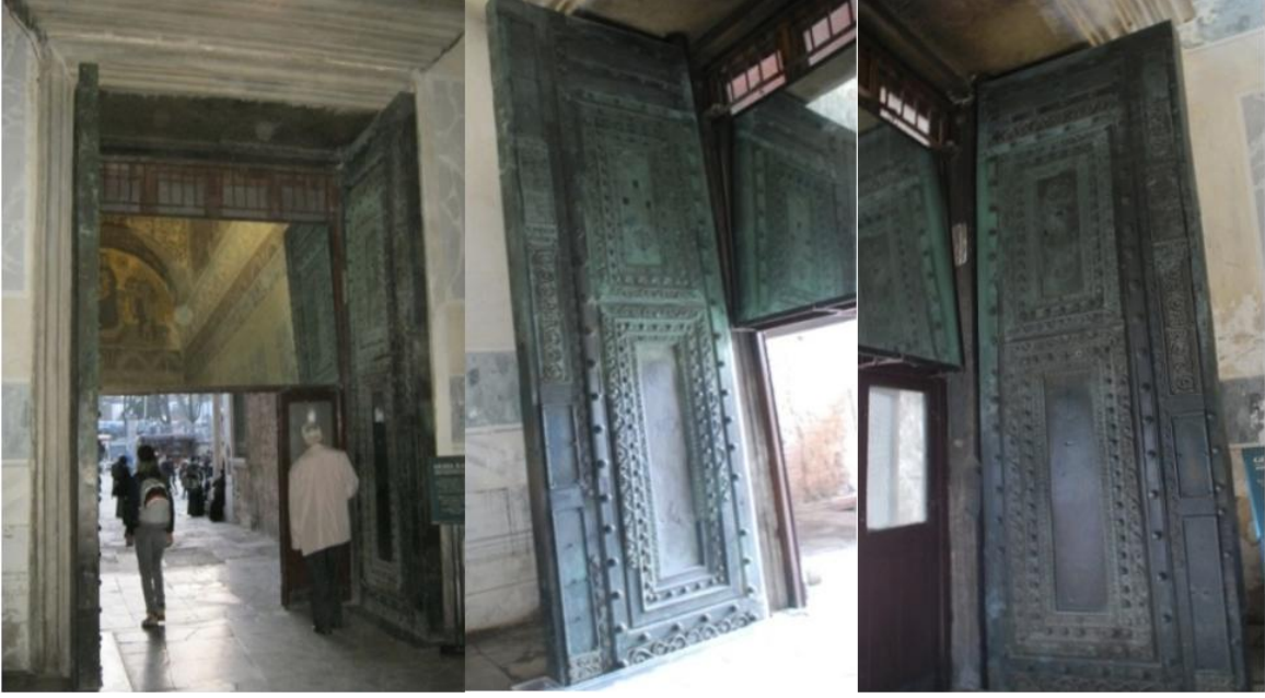
Şekil 3.47., Şekil 3.48. ve Şekil 3.49. Ayasofya'nın Narteksindeki Güzel Kapı, (Bilgen, 2011)
