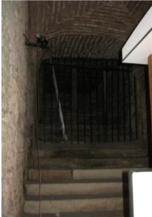
Şekil 3.75. Sultan Mahfili'ni Ayasofya'daki kapısına bağlayan kapı, (Bilgen, 2011)
