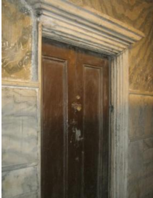
Şekil 3.89. Ayasofya'nın üst katındaki kuzey galerinin kuzey ve kuzeydoğu yan duvarlarındaki küçük bir odaya bağlanan kapı, (Bilgen, 2011)
