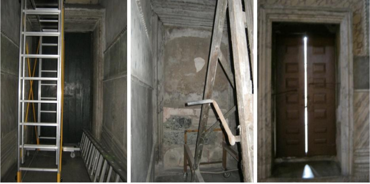
Şekil 3.59., Şekil 3.60. ve Şekil 3.61. Ayasofya'nın Naos mekânının güney yan duvarındaki kapılar, (Bilgen, 2011)
