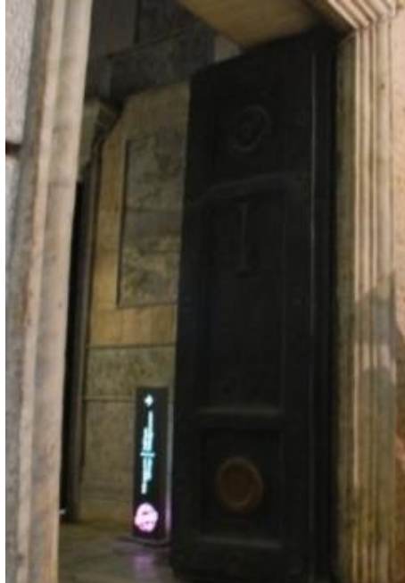
Şekil 3.9. Ayasofya'nın kuzey dış narteks kapısı (Bilgen, 2011)
