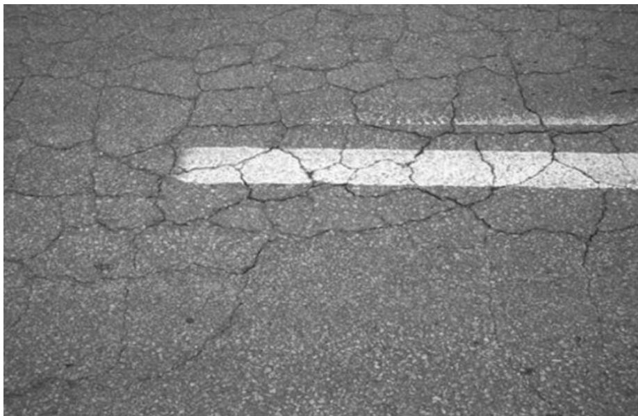
Şekil 1.5. Timsah sırtı çatlak (Bağdatlı, 2010).
