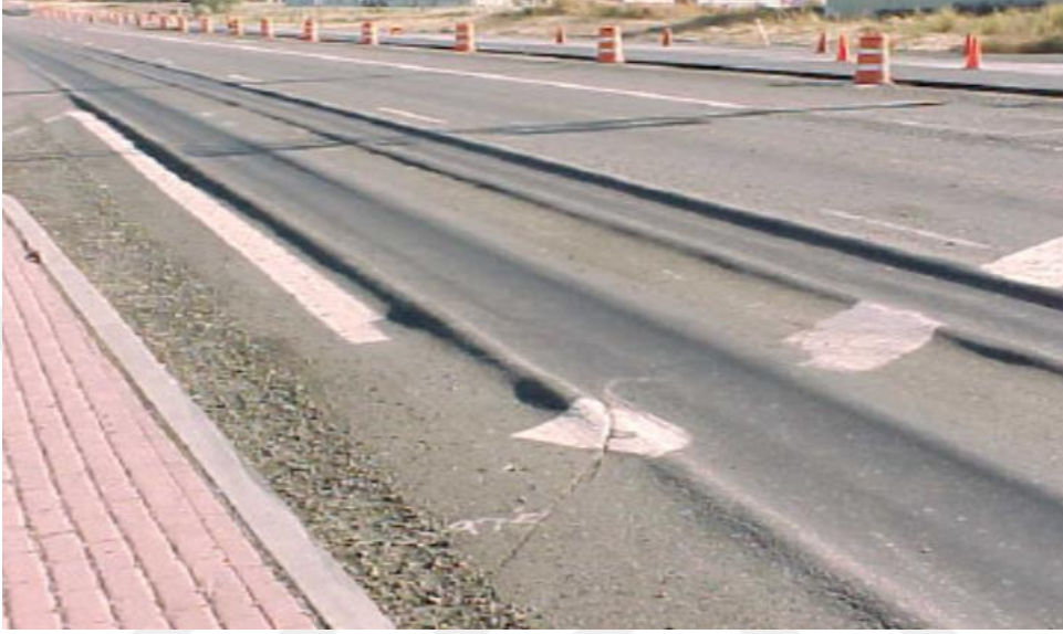
Őekil 1.6. Tekerlek izinde oturma (Terzi, 2004)
