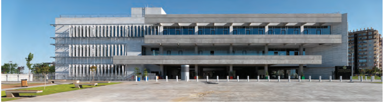
16. Giriş cephesinde brüt beton kirişlerin vurgulanması ile sağlanan tektonik algı
