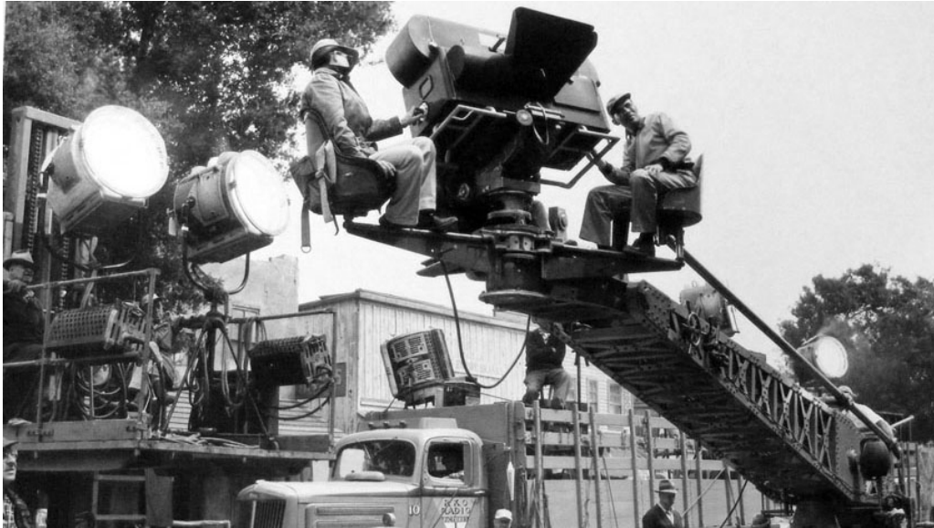
Fotoğraf 26. Natural Vision kamera rig sisteminin sette, iki operatörlü vinç üzerindeki kullanımı (Making and Editing The First 3D Color Film, Haziran 2018)
